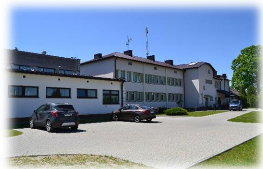
Utworzenie placu przy Domu Opieki Diennej w Maziarni
